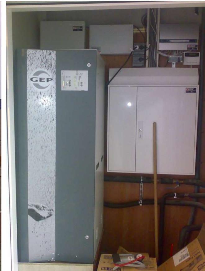
IRM-10 Wassermanager mit 2 Beton Zisternen a 20.000 Liter und Regenwasserfilter Trident 2.000 und automischer Filterreinigung. Das Regenwasser wird für die Toilettensülung verwendet
